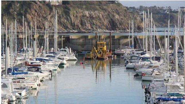
**Tous les trois ans, durant l'hiver, une opération de dragage est mise en place afin de retirer l'accumulation de sédiments due aux marées. Une entreprise vendéenne assure les travaux.**
